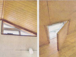
LDKの壁の上とキッチンの足下には、通風用の小窓を設けています。
