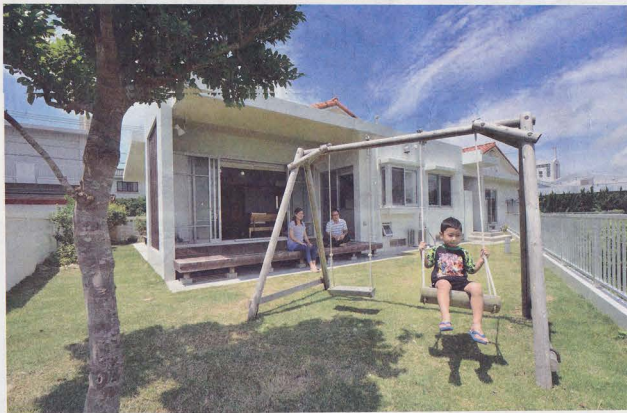
プランコを設置した北側の庭。ウッドデッキの屋根になるように庇(ひさし)を延ばして、半屋外空間を広く取りました
