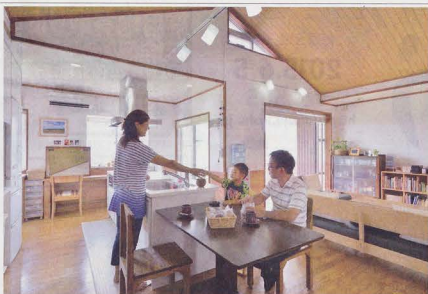
家族団らんの場であるLDKは、屋根の形状を生かした勾配天井、天井面に木の化粧材を貼り付けたほか、天井と壁の境や開口部の縁などにも木製の見切り材を取り付け、空間を立体的かつ装飾的に仕上げています
